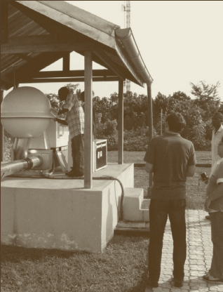
Installation de matériel à la station de surveillance des radionucléides RN13, à Édéa (Cameroun)
